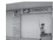
CDD a ser inaugurado, à Rua Marechal Deodoro
